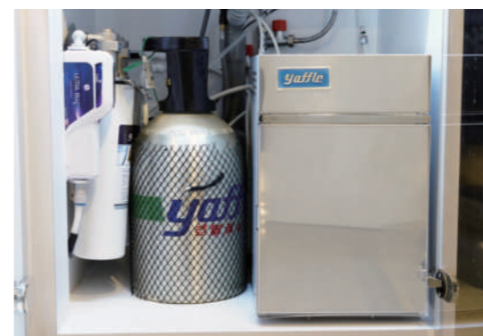
櫥下安裝：氣泡水主機、氣瓶、淨水器
