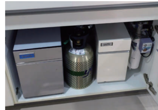
櫥下安裝：氣泡水主機、氣瓶、瞬間熱飲機、淨水器
