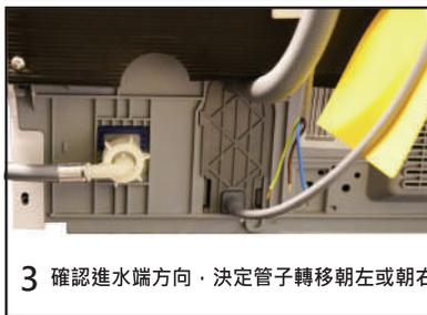
3 確認進水端方向，決定管子轉移朝左或朝右；再將螺母鎖緊後，即無法變換進水管方向。
